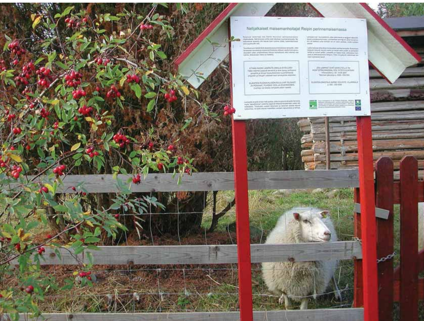
Virkistyskohteissa ovat tärkeitä sekä tiedottaminen että toimivat rakenteet. Laudoilla vahvistettu lammasperkko on kestävä aita, joka kestää kevyttä nojailemistakin.
